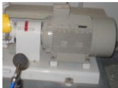
Messung von Lärmemissionen einer Pumpe
