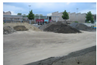
Zwischenlagerplatz für triagiertes Aushubmaterial
