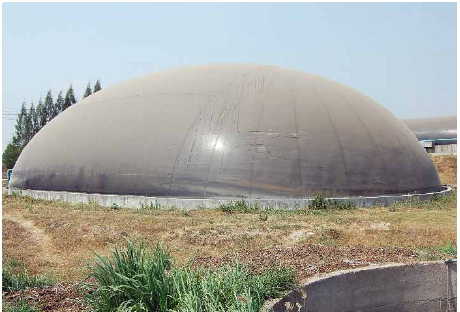
Bild 1: Das klimaschädliche Methan wird in Gasspeichern eingefangen, um es zu verstromen.
