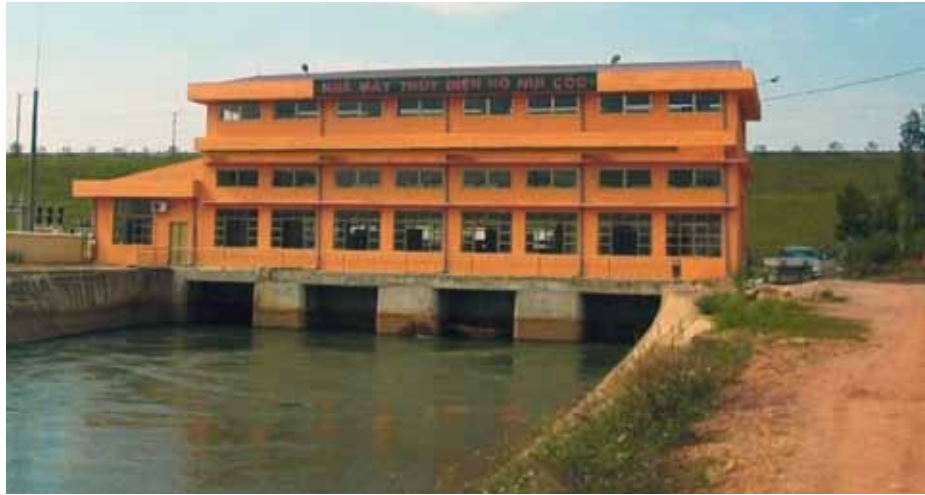
Bild 3 zeigt das Kleinwasserkraftwerk von Ho Nui Coc in Vietnam.
