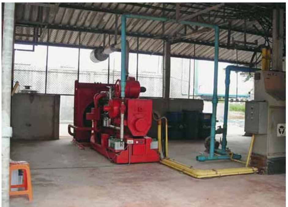
Bild 2: Der Gasmotor als Stromgenerator auf der Schweinefarm in Thailand.
